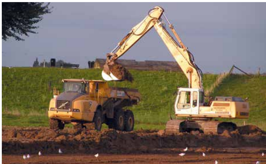
Figuur 5.9 Het benodigde grondverzet vindt hoofdzakelijk plaats met graafmachines en vrachtauto's
